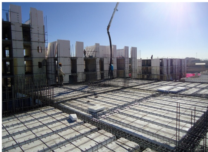
شکل ۳- اجرای سیستم دیوار باربر بتنی در پروژه مورد مطالعه
