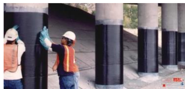
شکل 1- استفاده از روش EBR FRT در مقاوم سازی
