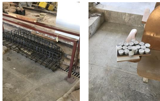
شکل 6- آرماتور بسته شده تیرها و اسپیسرهای بتنی ساخته شده
