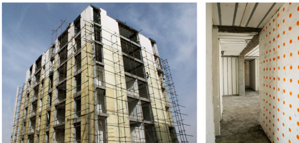
شکل ۴- اسکلت دیوار باربر بتنی و فضای داخلی در پروژه مورد مطالعه
