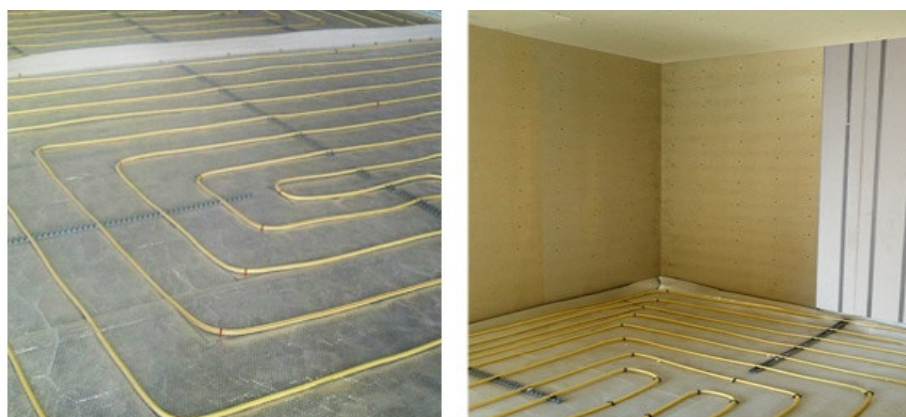
شکل ۵- سیستم گرمایش کفی اجرا شده در پروژه مورد مطالعه
