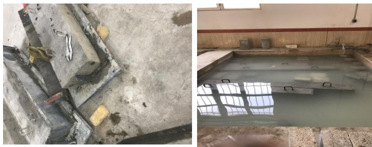
شکل 8- باز کردن قالب تیرها و قرار دادن داخل حوضچه آب به منظور عمل آوری
