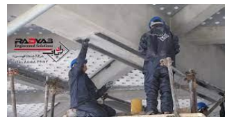
شکل 1- استفاده از روش EBR FRT در مقاوم سازی
